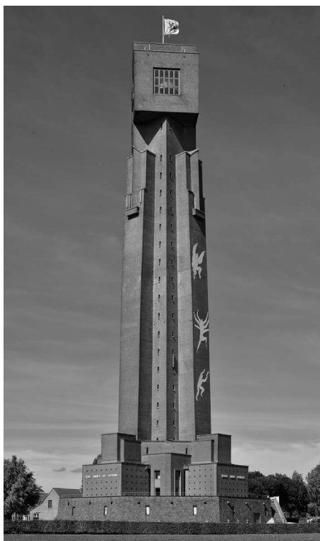
Ilustracja 17. Wieża Ijzer. Diksmuide, Belgia.
